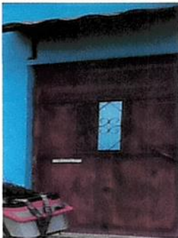
Foto 5: Reparación de portón de acceso principal.
